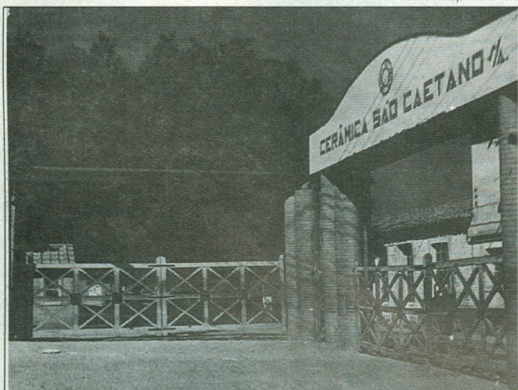
Entrada principal da Cerâmica São Caetano S.A., na década de 30
